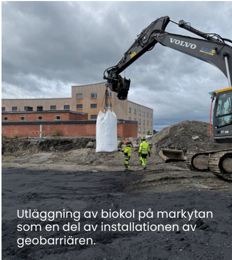
Biokol läggs ut över hela ytan för att skapa ett sammanhängande barriärlager i markkonstruktionen.
