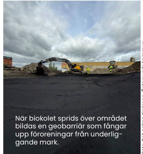
Biokol läggs ut över hela ytan för att skapa ett sammanhängande barriärlager i markkonstruktionen.
